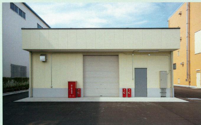
危険物倉庫(4類)
